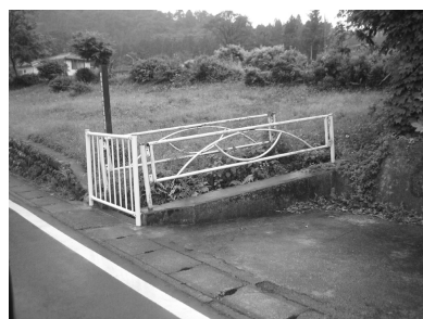
和田町水路防護柵改修
